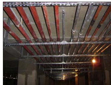
일반가대 및 클램프 설치 예
